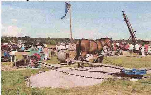
Mit dem Göpel, von zwei Pferden gezogen, wurde über eine am Boden verlaufende Kardanwelle eine Stiften-Dreschmaschine angetrieben.
