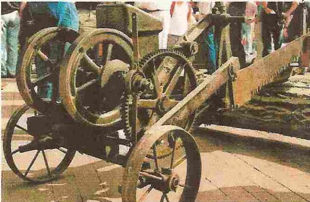
Beim Bergsträßer Schleppertreffen, im September 2009 in Hemsbach, war eine amerikanische Motorsäge Baujahr 1923 zu besichtigen, die damals zum Ablängen von Baumstämmen und zum Brennholzschneiden eingesetzt wurde. In etwas abgeänderter Ausführung konnte sie auch zum Fällen der Bäume verwendet werden.
