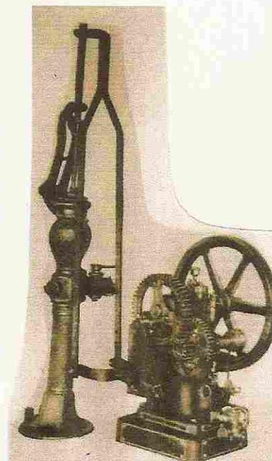
Diese Abbildung aus dem Jahre 1902 zeigt einen Stationärmotor der Firma „Western Malleable & Grey in Milwaukee“ der eine Wasserpumpe antreibt. Ähnlich muss man sich auch das Pumpenaggregat mit dem Aermotor vorstellen. Der Aermotor war bei einer Ausstellung für Stationärmotoren in Heuchelheim Kleingen zu besichtigen.
